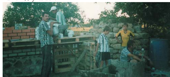
Використання ракушняку замість лампачу в сучасному будівництві
